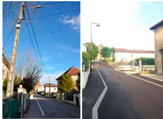
Travaux Grande rue : Avant/Après enfouissement des réseaux électriques/Création de trottoirs
