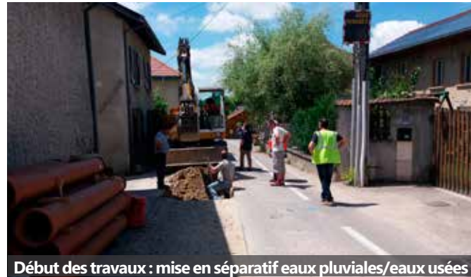
Début des travaux : mise en séparatif eaux pluviales/eaux usées
