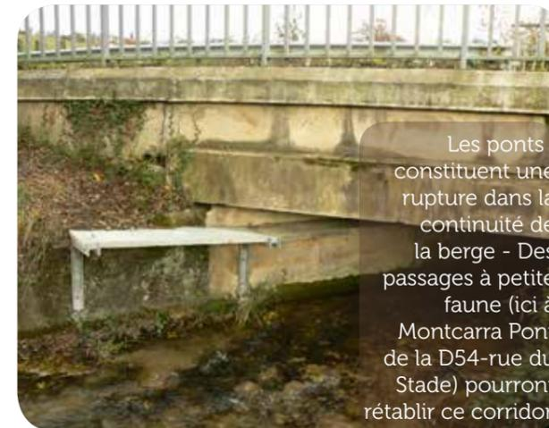
Les ponts constituent une rupture dans la continuité de la berge - Des passages à petite faune (ici à Montcarra Pont de la D54-rue du Stade) pourront rétablir ce corridor
