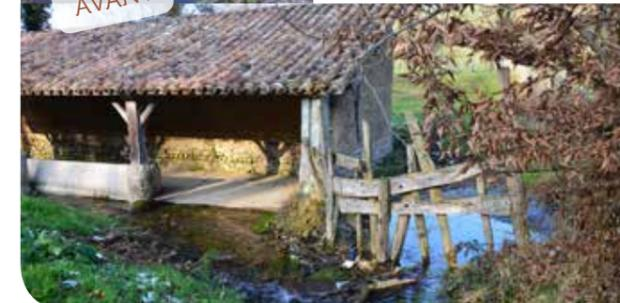
◀ Lavoir de l'étang ▶ Le mur en pisé du lavoir de l'étang était menacé par l'eau de la rivière au niveau de l'abreuvement des bêtes. Pour sa protection, un abreuvoir a donc été réalisé. De plus, il permet aux vaches de venir boire sans piétiner dans l'eau.
